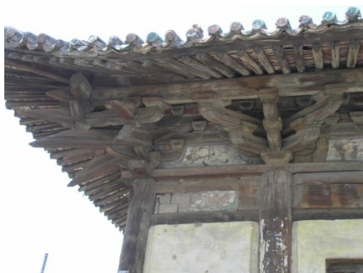
图八 大殿前檐南侧柱头铺作及转角铺作
