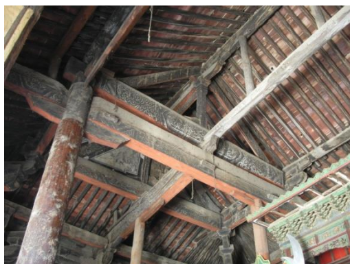
图六 大殿明间南缝梁架
