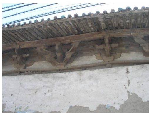
图一一 大殿后檐明间铺作
