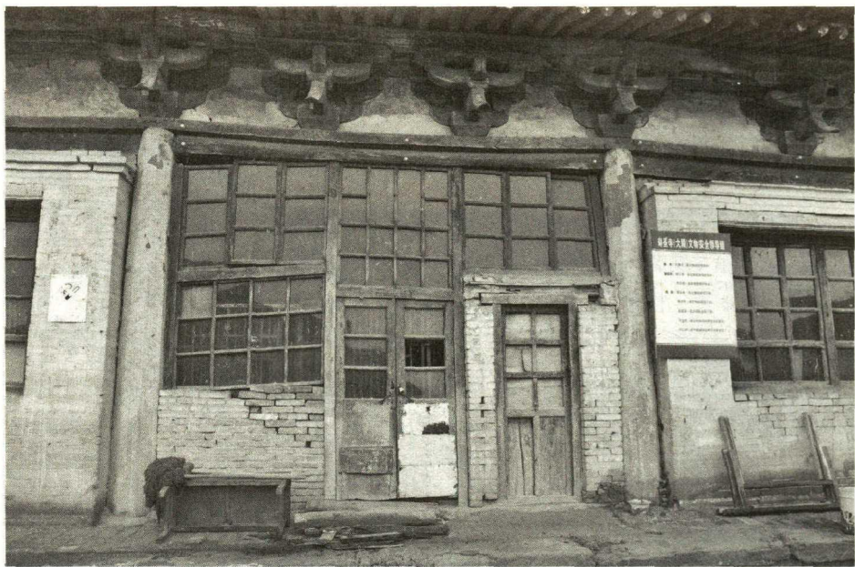
图八 寿圣寺大殿前檐明间
