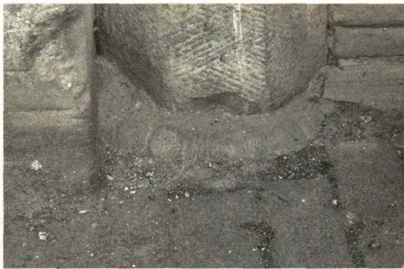
图一〇 寿圣寺大殿前檐西侧平柱及柱础
